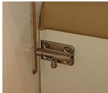
座板ロックが解除された状態
